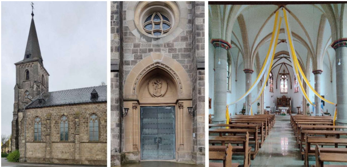
Abb. 353: Johannes-Baptist Kirche in Arolsen – Südwest-Ansicht, Portal, Blick zum Chor
