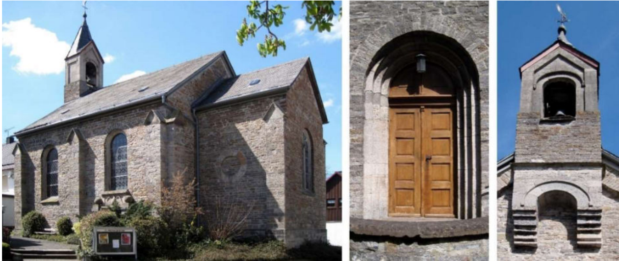
Abb. 337: Kirche in Ottlar – Ansicht von Ost, West-Portal, Dachreiter
