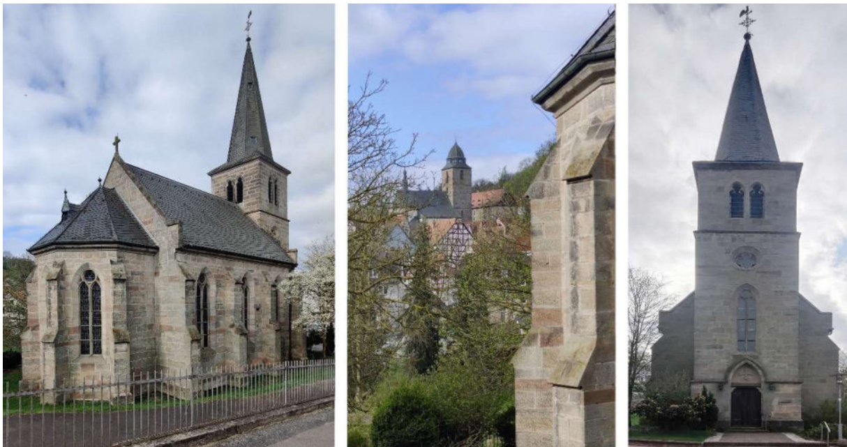
Abb. 350: Ev. Kirche Naumburg – Süd-Ansicht, Blick zur Katholischen Kirche, West-Ansicht
