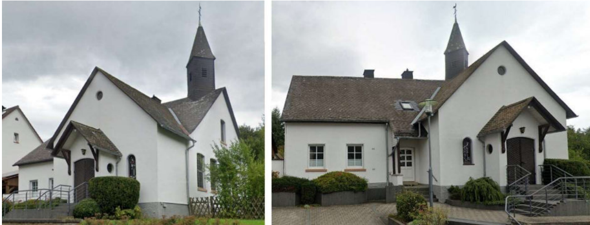
Abb. 366: Katholische Kirche in Nieder-Schleidern – Südost- und Süd-Ansicht
