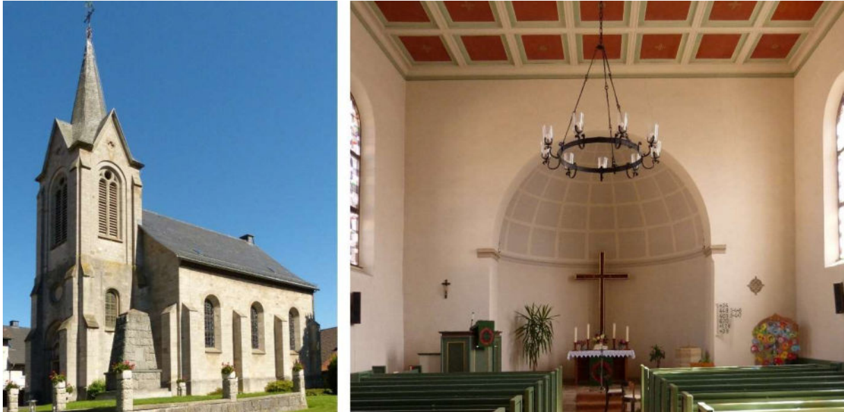
Abb. 345: Kirche in Vasbeck – Südwest-Ansicht, Innenraum von West
