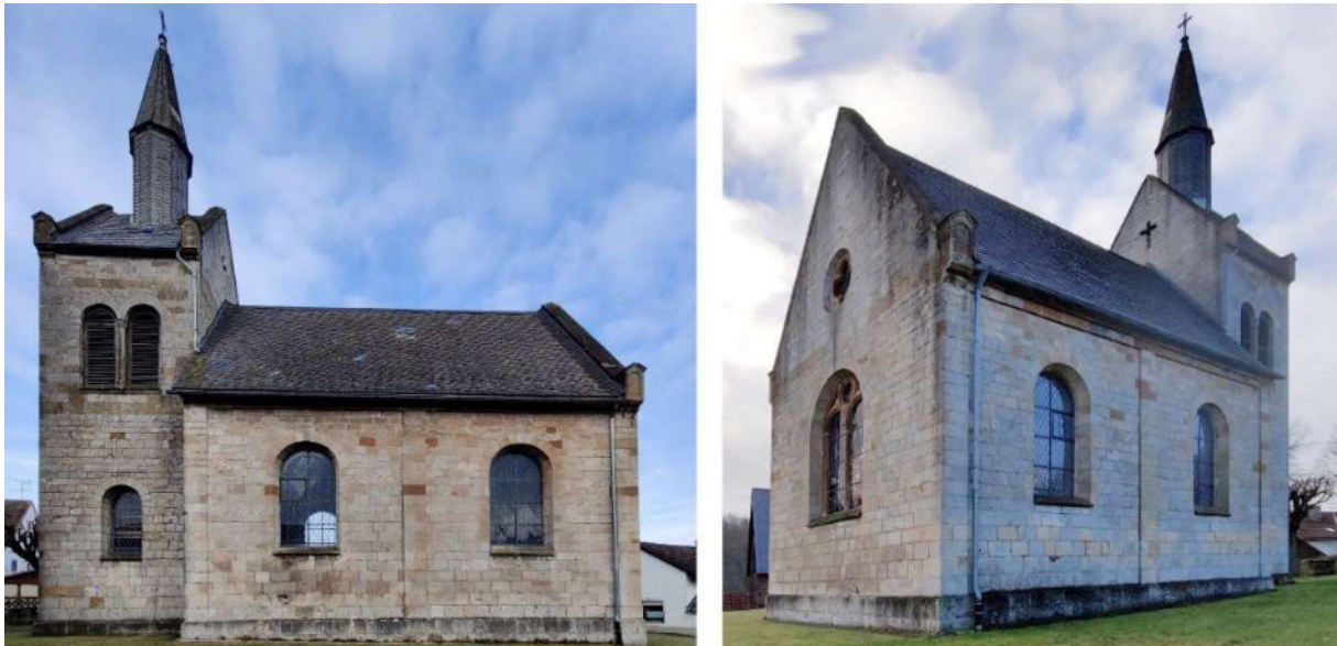
Abb. 338: Evangelische Kirche in Eppe – Süd- und Nordost-Ansicht
