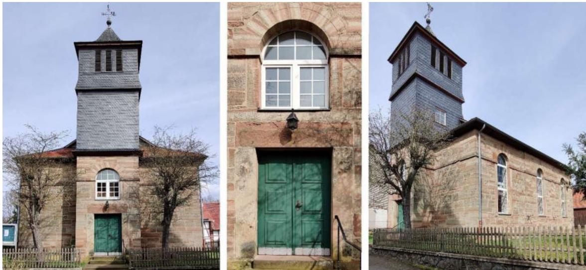
Abb. 318: Kirche in Dainrode – Süd-Ansicht, Süd-Portal, Südost-Ansicht
