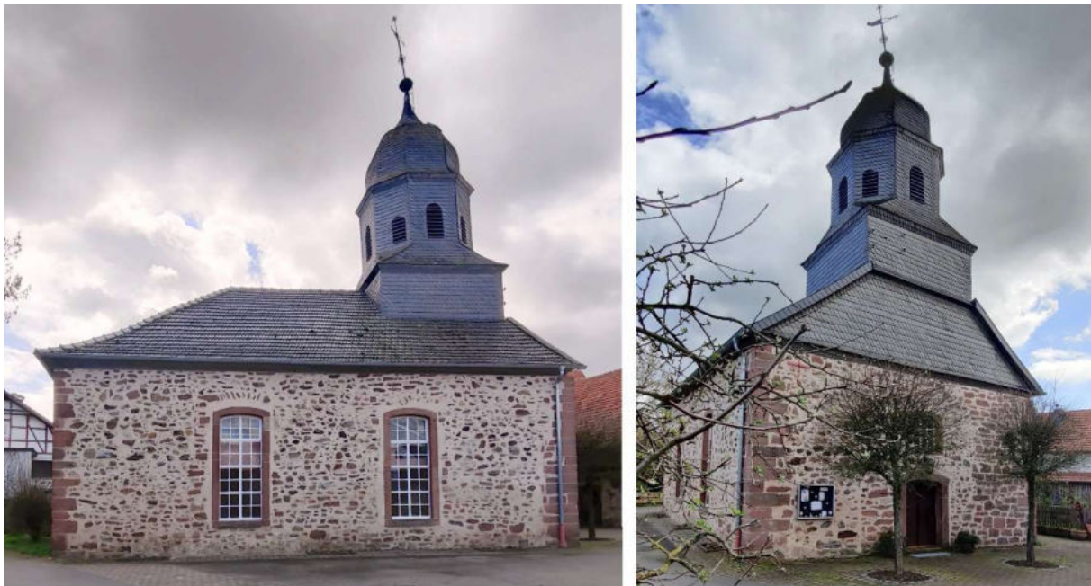
Abb. 294: Kirche in Oberurff – Außen-Ansicht, Altarraum, Orgelempore
