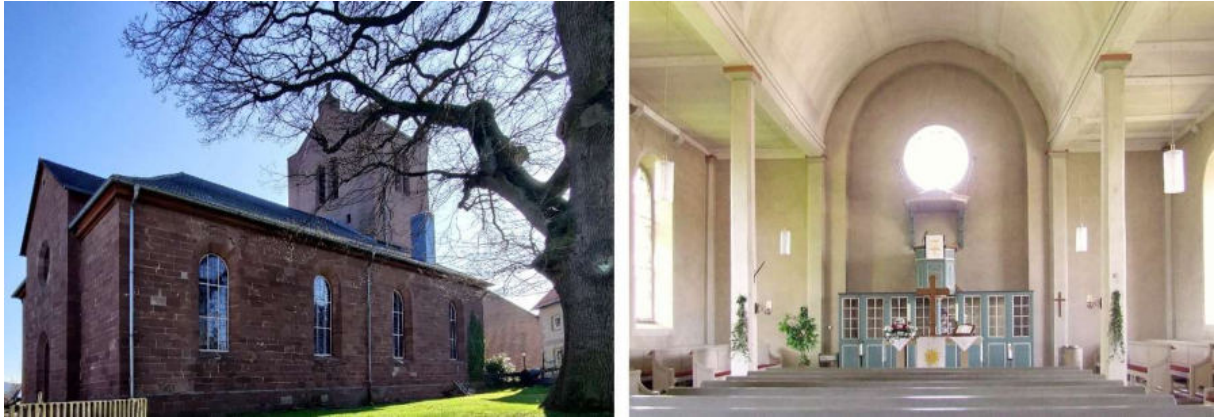
Abb. 322: Kirche in Sielen – Nordost-Ansicht, Blick in den Altarraum [4]
