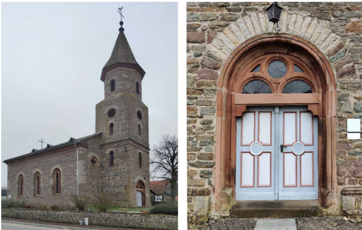
Abb. 332: Kirche in Neukirchen – West-Ansicht, Südwest-Portal
