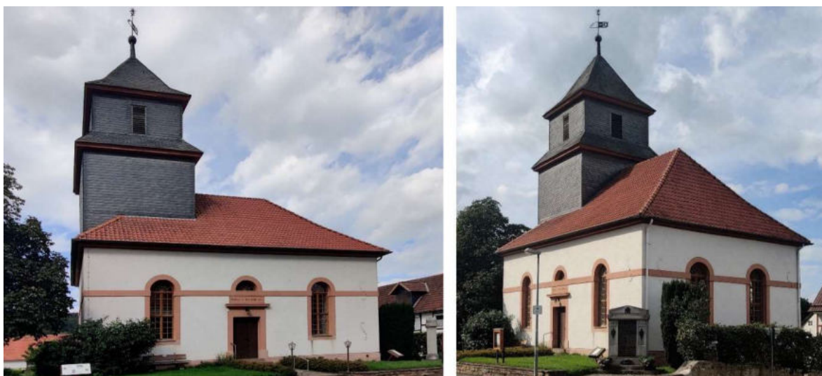
Abb. 306: Kirche in Niederlistingen – Süd- und Südost-Ansicht
