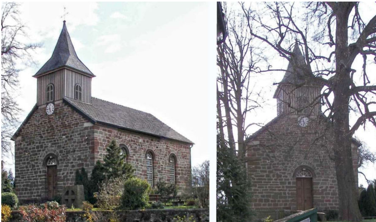
Abb. 330: Kirche in Dehringhausen – Nordost- und Ost-Ansicht (von links)
