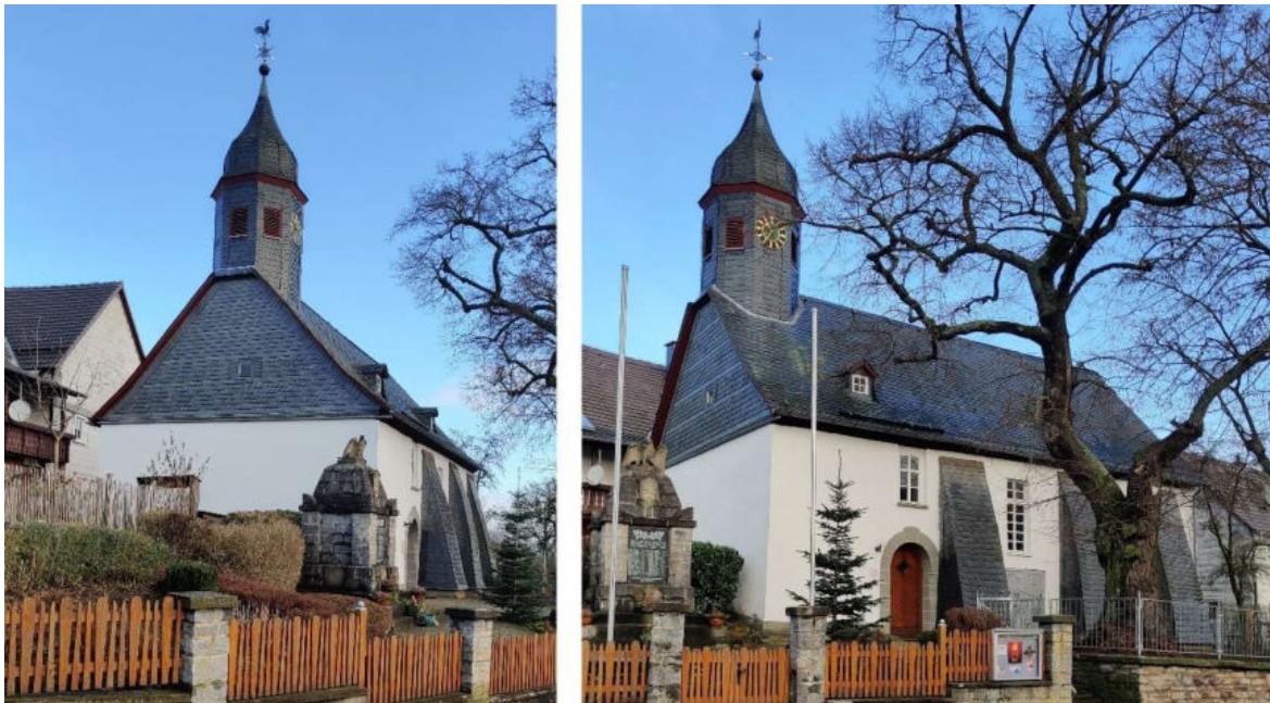
Abb. 308: Kirche in Rhenegge – West- und Südwest-Ansicht
