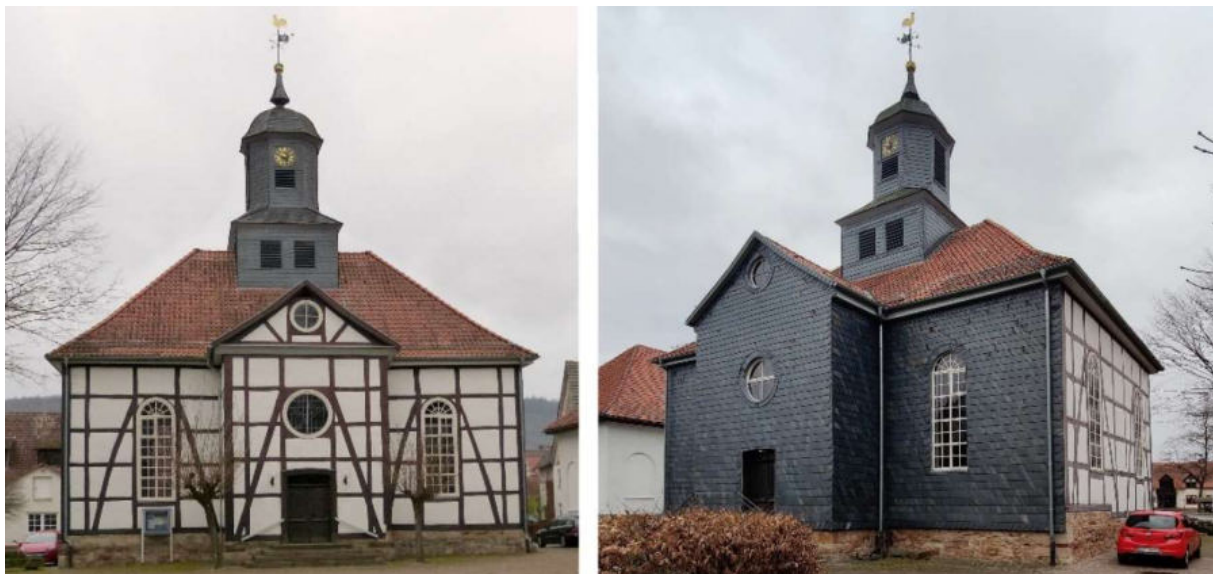
Abb. 303: Kirche in Gieselwerder – Südost- und West-Ansicht
