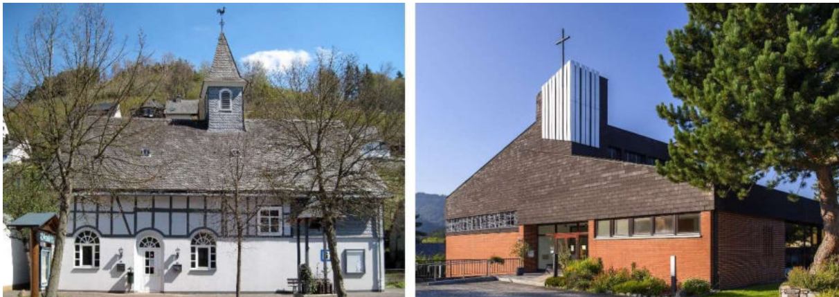
Abb. 305: Kirchen in Schwalefeld – Alte Kapelle, Neue Pilgerkirche
