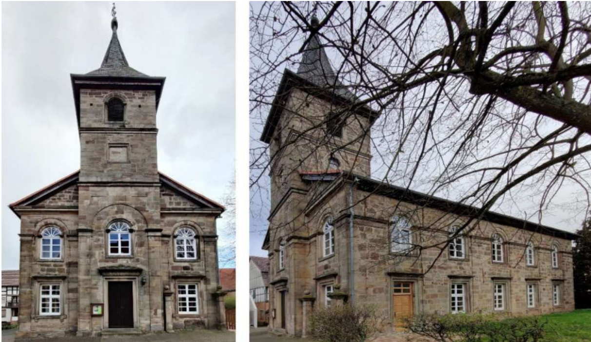
Abb. 320: Kirche in Haddamar – West- und Südwest-Ansicht
