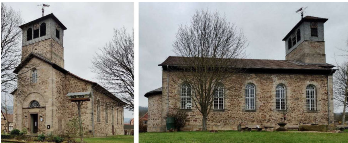
Abb. 314: Kirche in Oedelsheim – Nordost- und Süd-Ansicht
