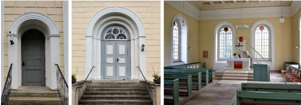
Abb. 325: Kirche in Hemfurth – West- und Süd-Portal, Altarraum [4]
