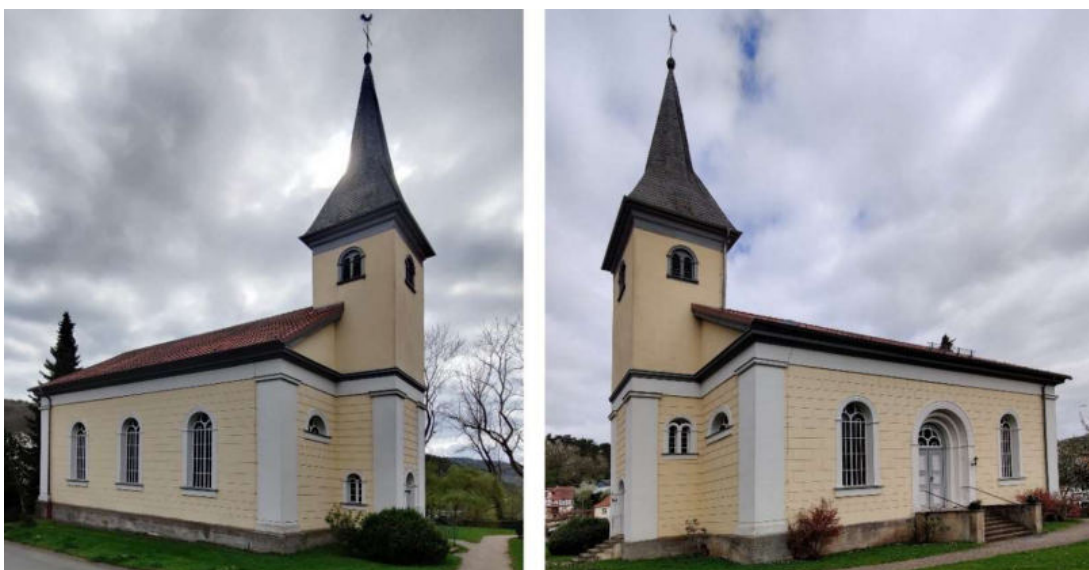
Abb. 324: Kirche in Hemfurth – Nordwest- und Südwest-Ansicht
