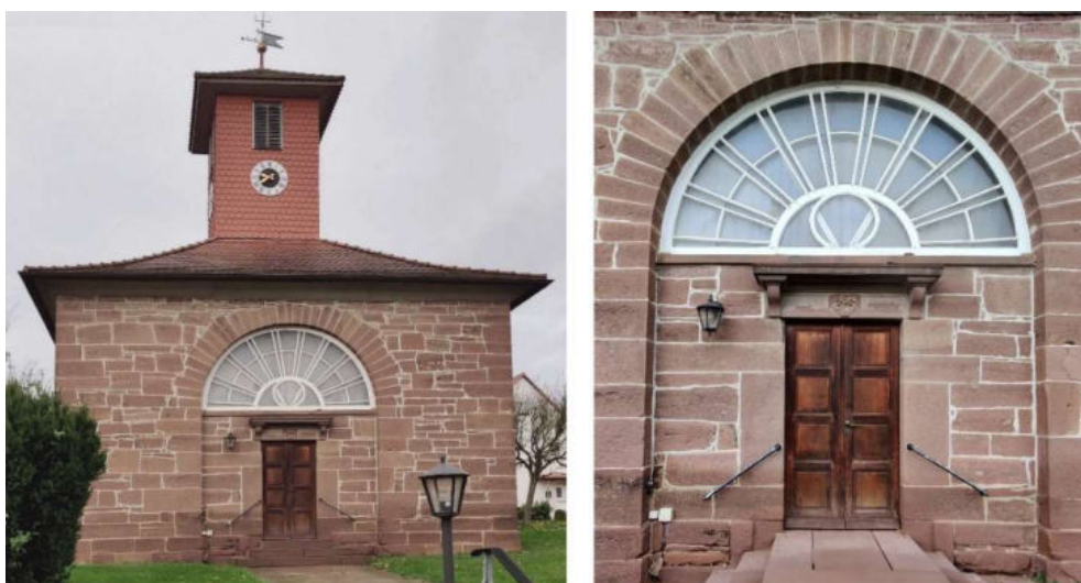
Abb. 309: Kirche in Schachten – West-Ansicht und West-Portal (von links)
