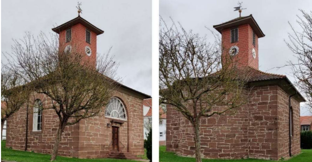
Abb. 310: Kirche in Schachten – Nordwest- und Ost-Ansicht (von links)
