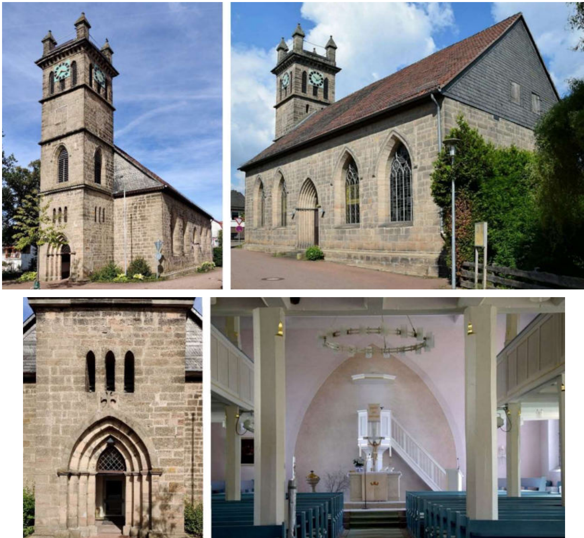
Abb. 328: Kirche in Wrexen – oben: Südwest- und Südost-Ansicht unten: Turm-Portal, Innenraum mit Altar [4] (jeweils von West)
