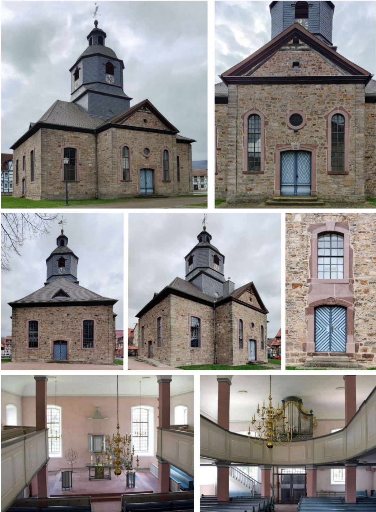
Abb. 297: Kirche in Veckerhagen – oben: Nordost- und Ost-Ansicht mittig: West- und Südwest-Ansicht, Süd-Portal; unten: Innen-Ansichten (jeweils von links)
