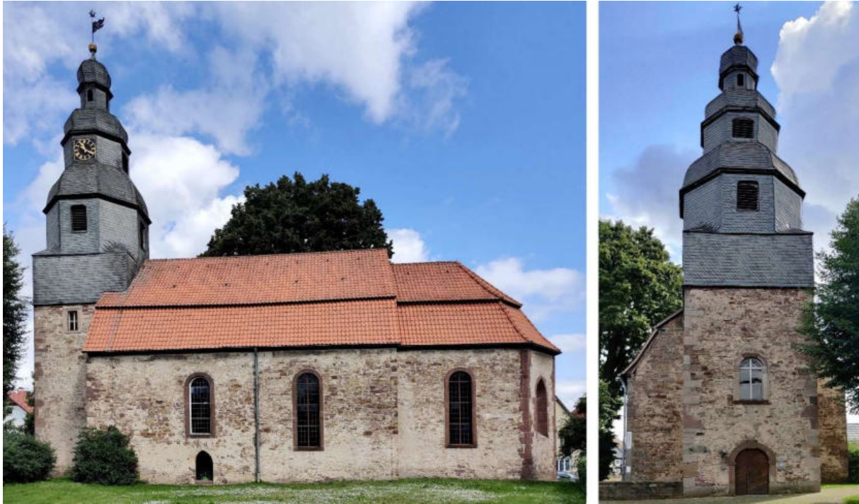
Abb. 230: Kirche in Deisel – Süd- und West-Ansicht (von links)
