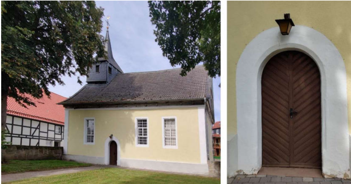
Abb. 249: Kirche in Herbsen – Süd-Ansicht, Süd-Portal
