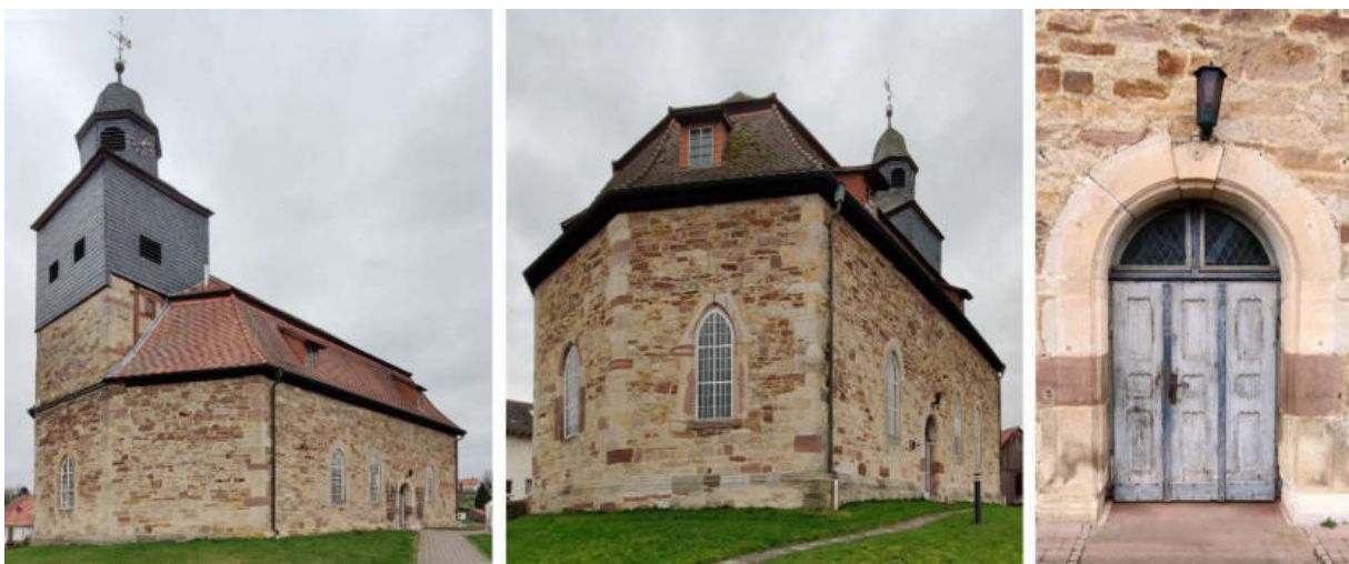
Abb. 254: Kirche in Hombressen – Südwest- und Nordost-Ansicht (von links)
