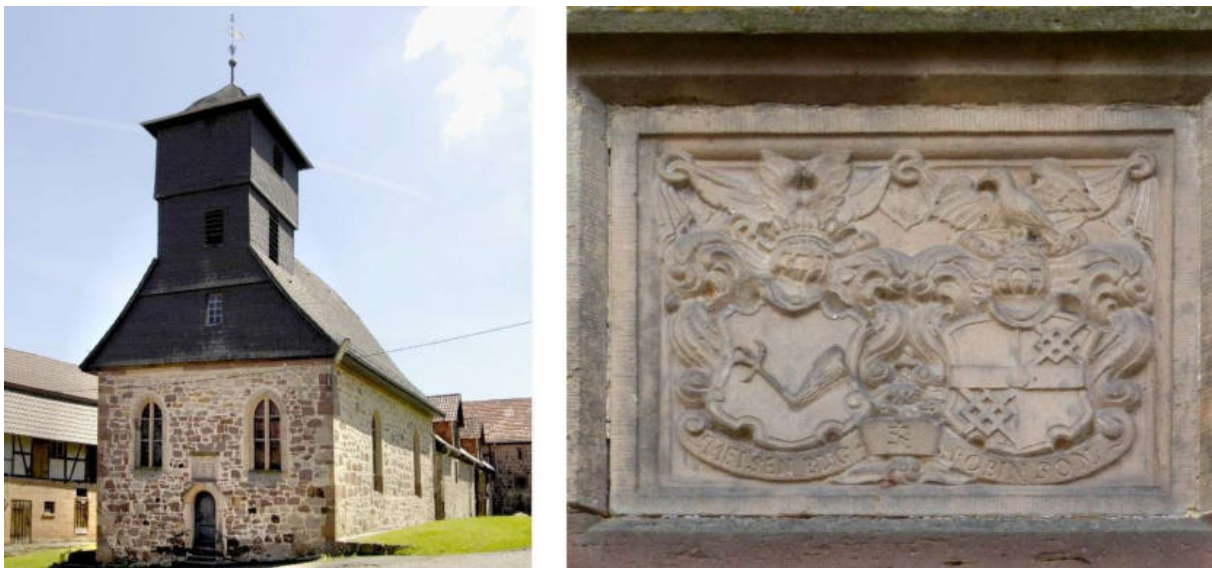
Abb. 250: Kirche in Riede – Nord-Ansicht, Wappen über dem Portal
