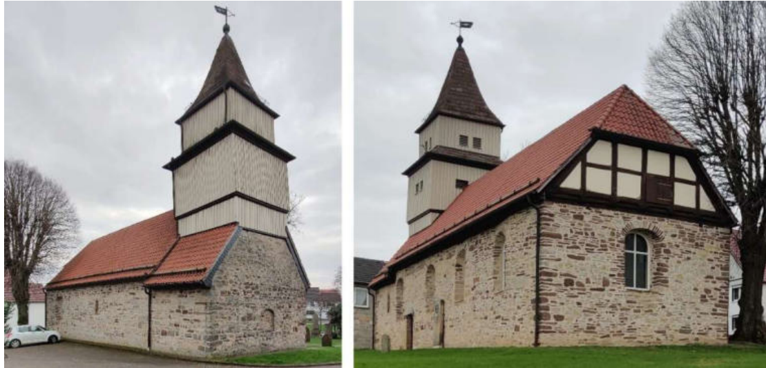
Abb. 246: Kirche in Langenthal – Nordwest- und Südost-Ansicht
