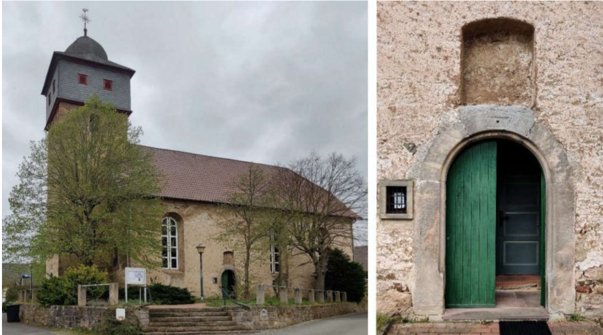
Abb. 252: Kirche in Kleinern – Süd- Ansicht, Süd-Portal (von links)
