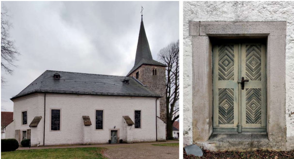
Abb. 232: Kirche in Höringhausen – Nordost-Ansicht, Süd-Portal
