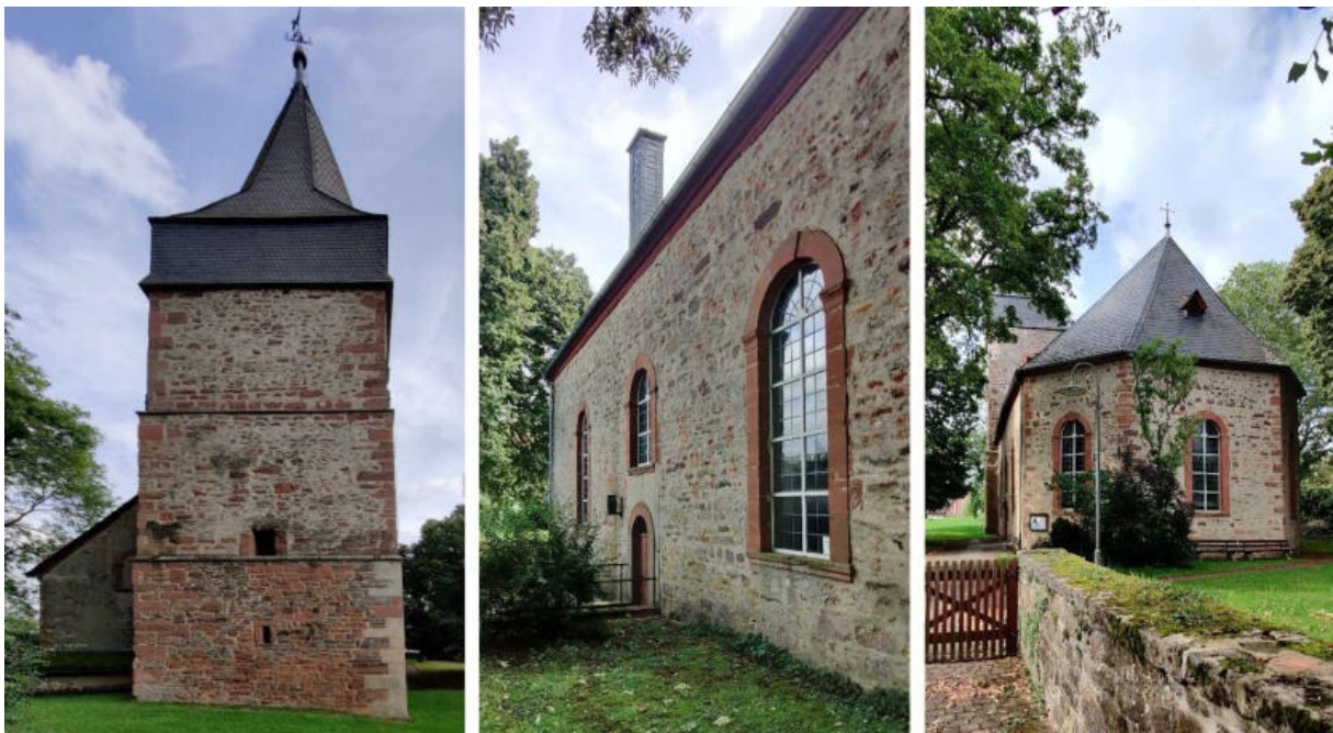
Abb. 235: Kirche in Sachsenberg – West-Ansicht, Nordwand des Schiffs, Ost-Ansicht
