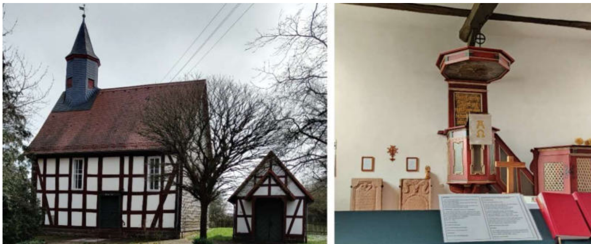
Abb. 270: Kirche in Louisendorf – Nordwest-Ansicht, Blick zur Kanzel
