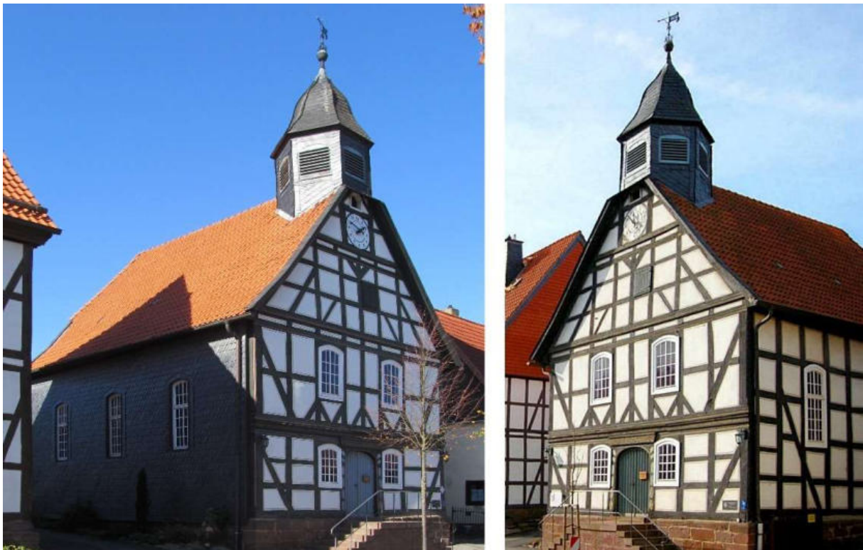
Abb. 274: Kirche in Schöneberg – Südost- und Nordost-Ansicht [7]
