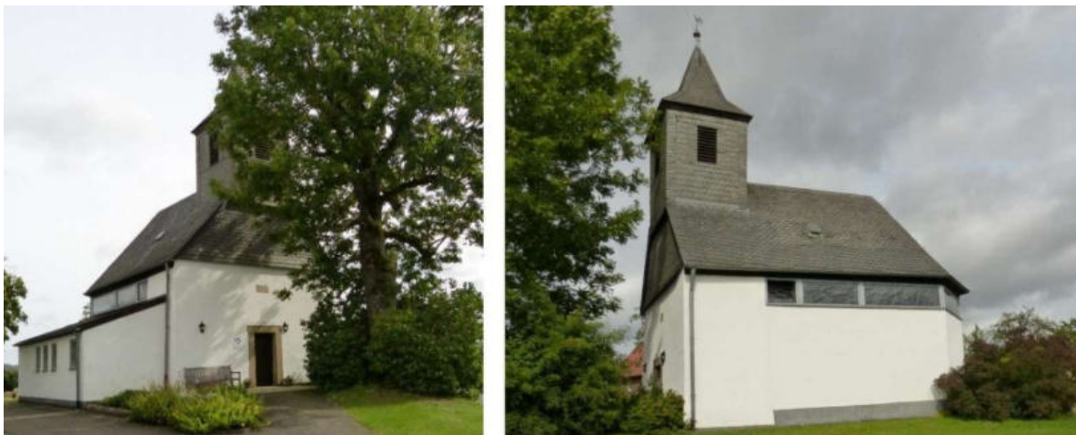
Abb. 265: Kirche in Rhadern – Ansichten von Südwest und Südost (von links)
