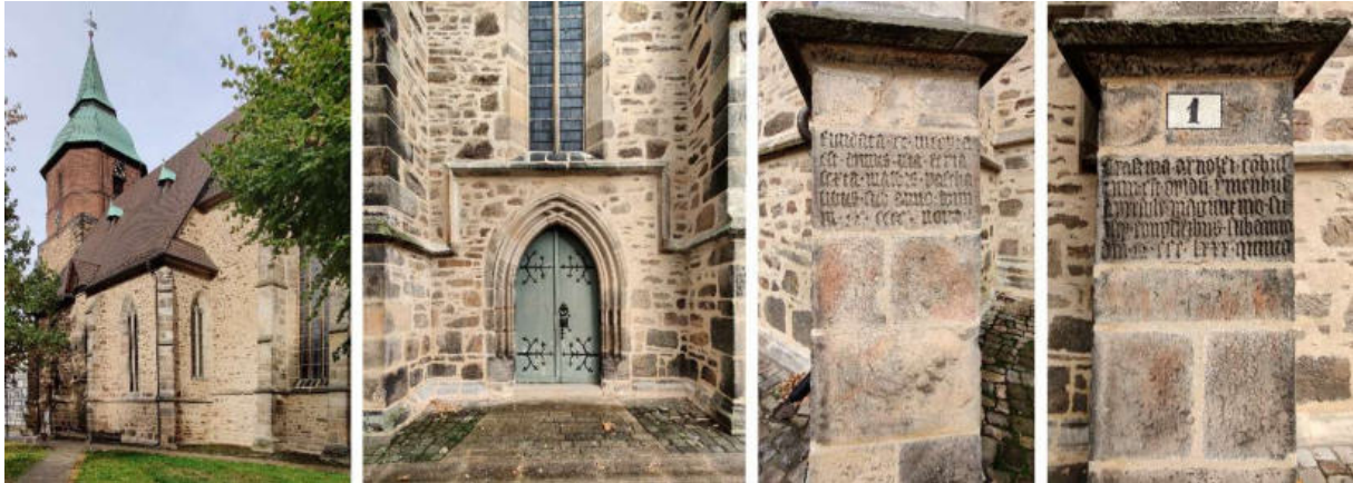
Abb. 205: Kirche in Immenhausen – Südost-Ansicht, Süd-Portal, Inschriftsteine (von links)
