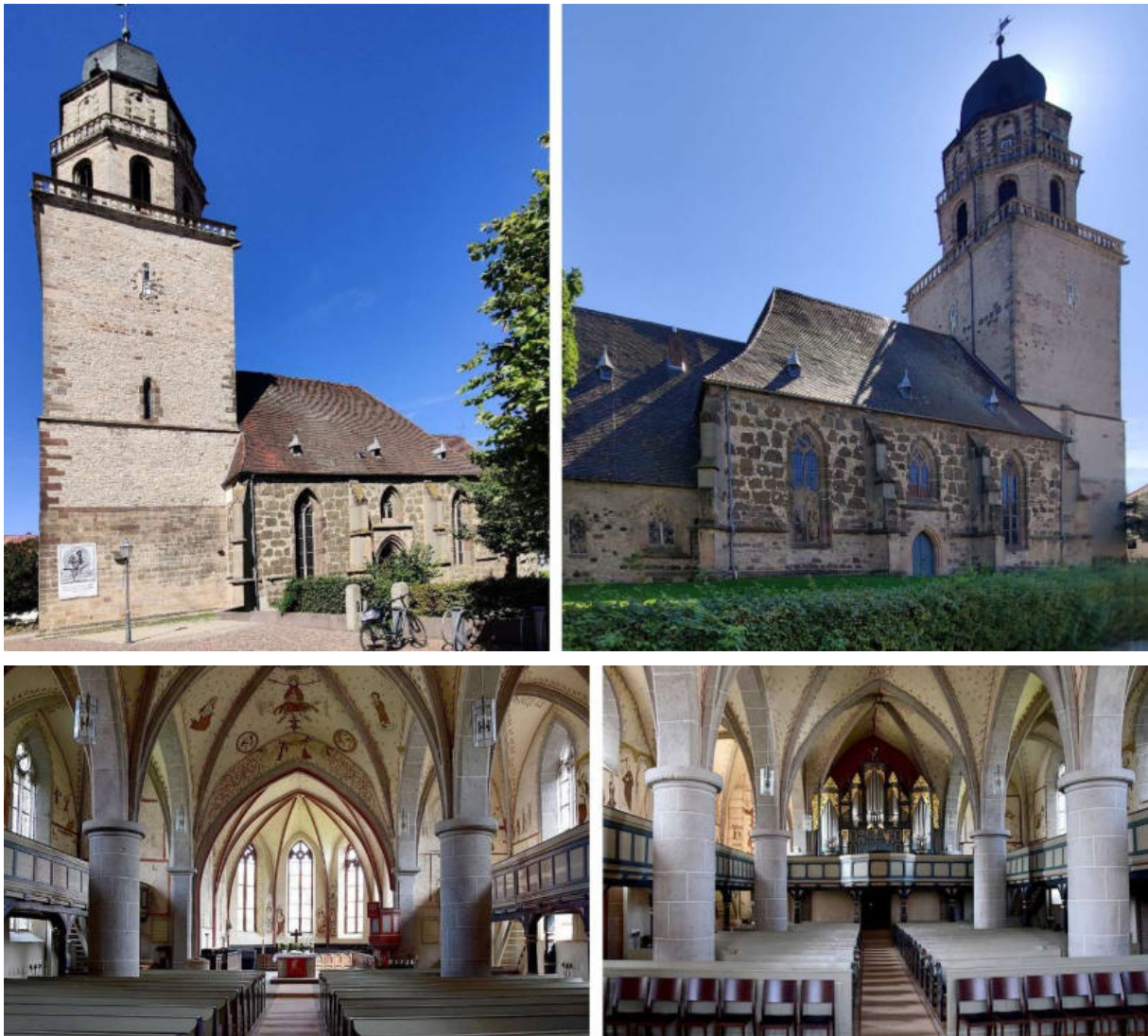
Abb. 207: Kirche in Zierenberg – oben: Südost-Ansicht, Nord-Ansicht unten: Blick zum Chor [4], Blick aus dem Chor zur Orgel [4] (jeweils von links)
