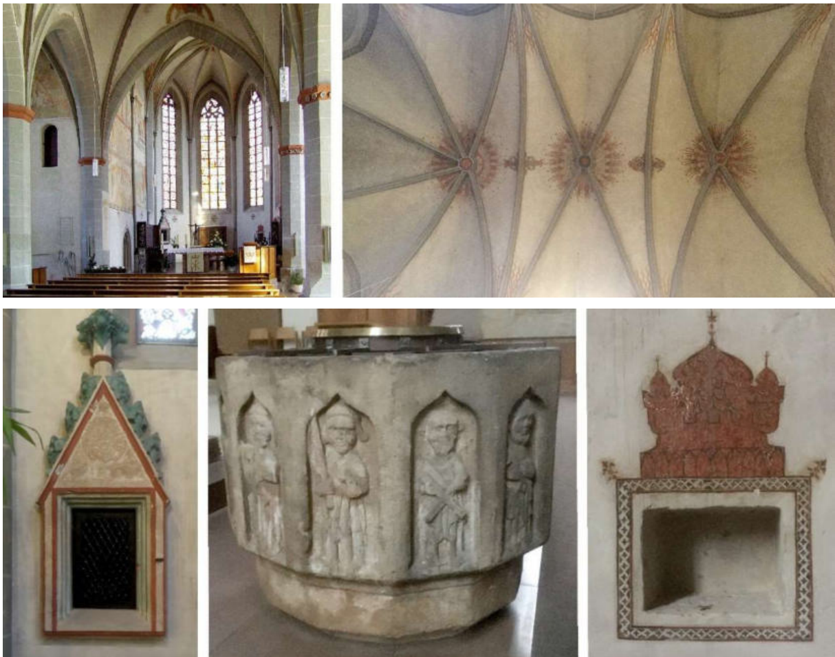
Abb. 206: Kirche in Immenhausen – oben: Blick in den Chor, Chor-Gewölbe unten: Sakramentsnische, Taufstein, Gerätenische ([4] jeweils von links)
