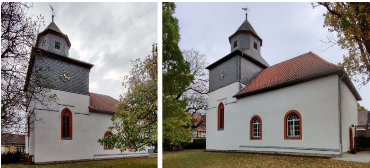
Abb. 222: Kirche in Ehrsten – Nordost- und Nordwest-Ansicht (von links)
