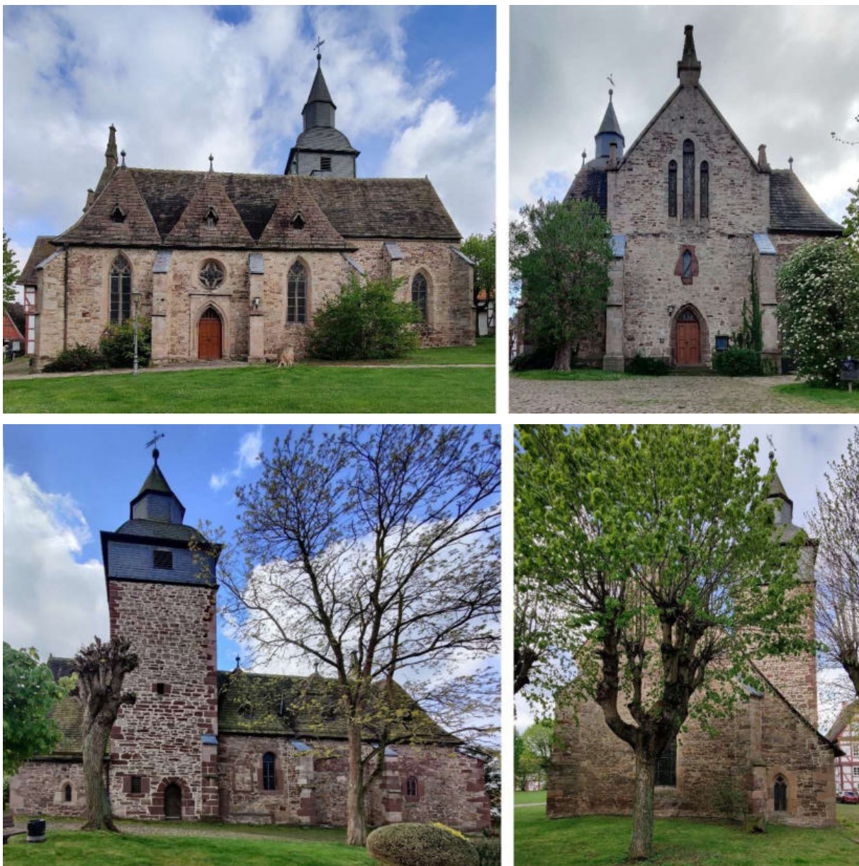
Abb. 196: Kirche in Trendelburg – oben: Süd-Ansicht, West-Ansicht unten: Nord- und Ost-Ansicht (jeweils von links)
