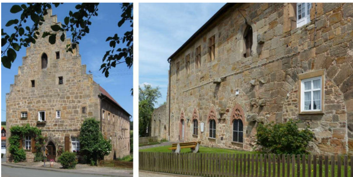
Abb. 220: Volkhardinghausen – Süd- und Südwest-Ansicht (von links)
