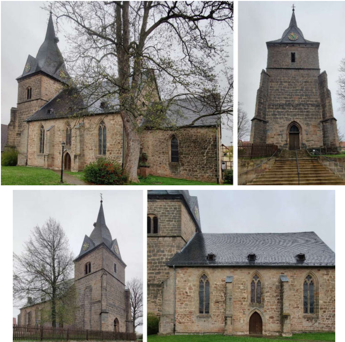
Abb. 153: Kirche in Landau – oben: Südost-Ansicht, West-Ansicht unten: Nordwest-Ansicht, Süd-Ansicht (jeweils von links)
