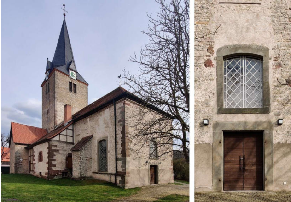
Abb. 141: Kirche in Breuna – Nordwest-Ansicht, West-Portal
