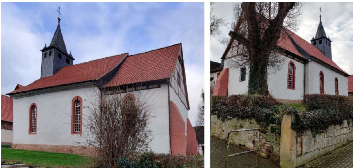
Abb. 162: Kirche in Ober-Waroldern – Südost-Ansicht, Nordost-Ansicht (von links)
