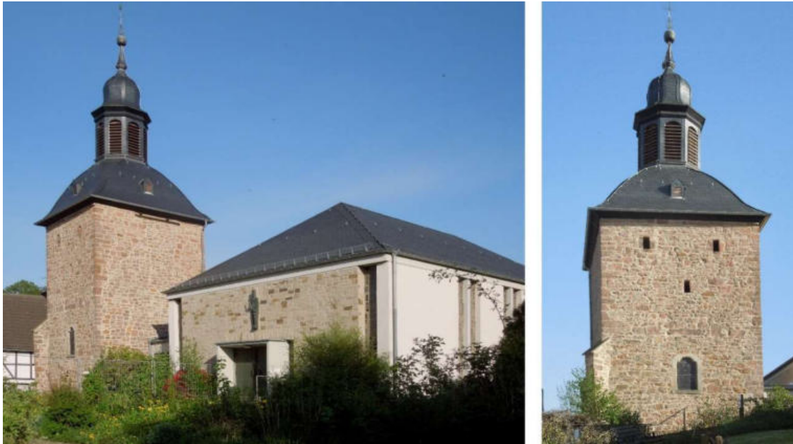
Abb. 157: Kirche in Ungedanken – Südwest- und Süd-Ansicht (von links)
