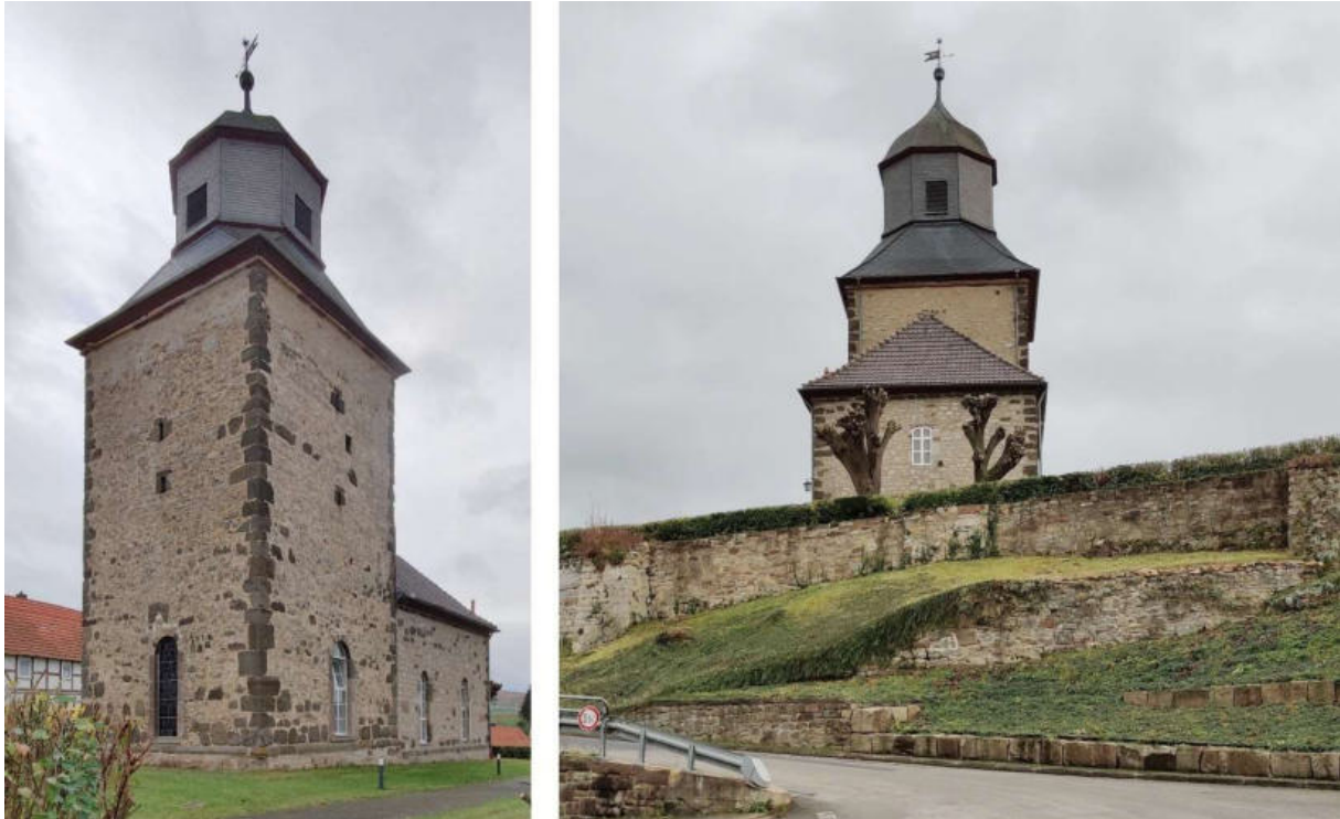
Abb. 139: Kirche in Meimbressen – Nordost- und West-Ansicht (von links)
