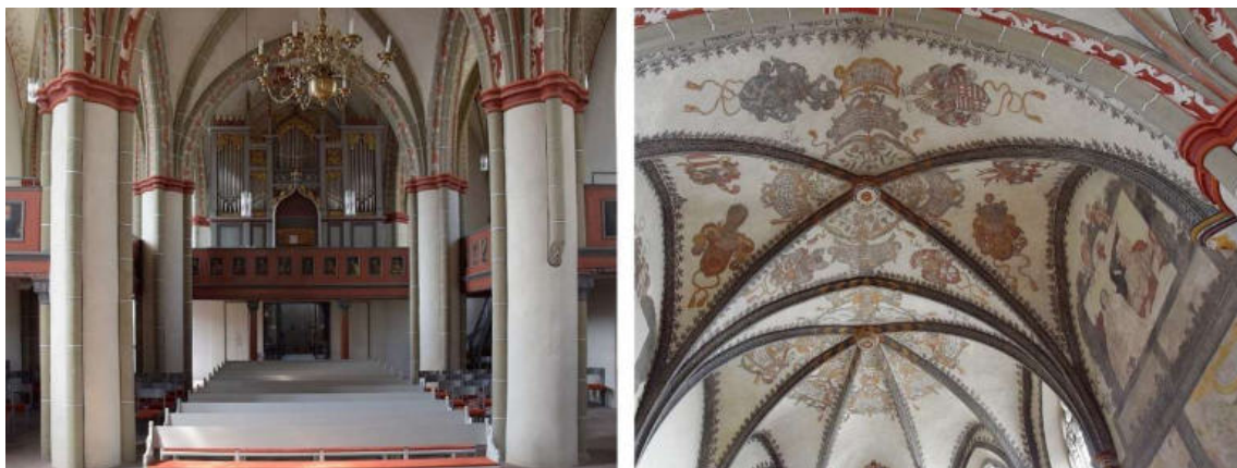
Abb. 177: Kirche in Mengeringhausen – oben: Südwest-, Nordost- und Nord-Ansicht; mittig: Blick aus dem Langhaus zum Chor, Hochaltar unten: Blick zur Orgel, Renaissance-Bemalung des Chorgewölbes (jeweils von links)
