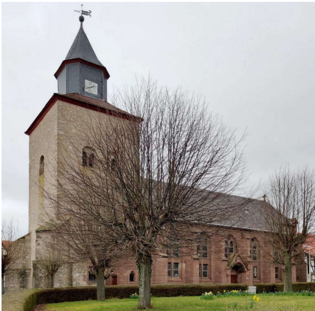
Abb. 121: Kirche in Westuffeln – oben: Südwest-Ansicht;
