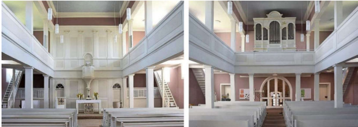
Abb. 110: Kirche in Vöhl – oben: Nord-, Südwest -Ansicht (von links); unten: Innenraum [4]
