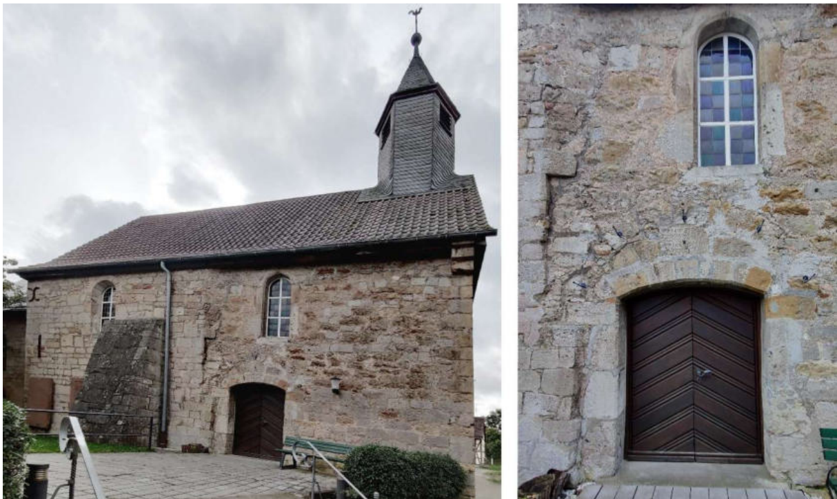
Abb. 94: Kirche in Lengefeld – Nord-Ansicht, Nord-Portal (von links)
