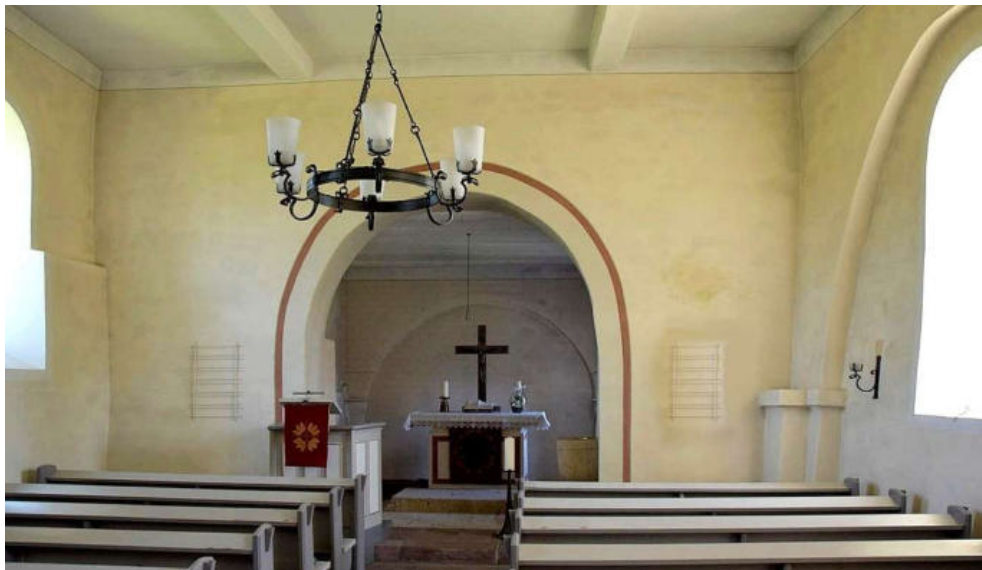
Abb. 96: Kirche in Gembeck – oben: Südwest- und Süd-Ansicht; unten: Blick zum Chor
