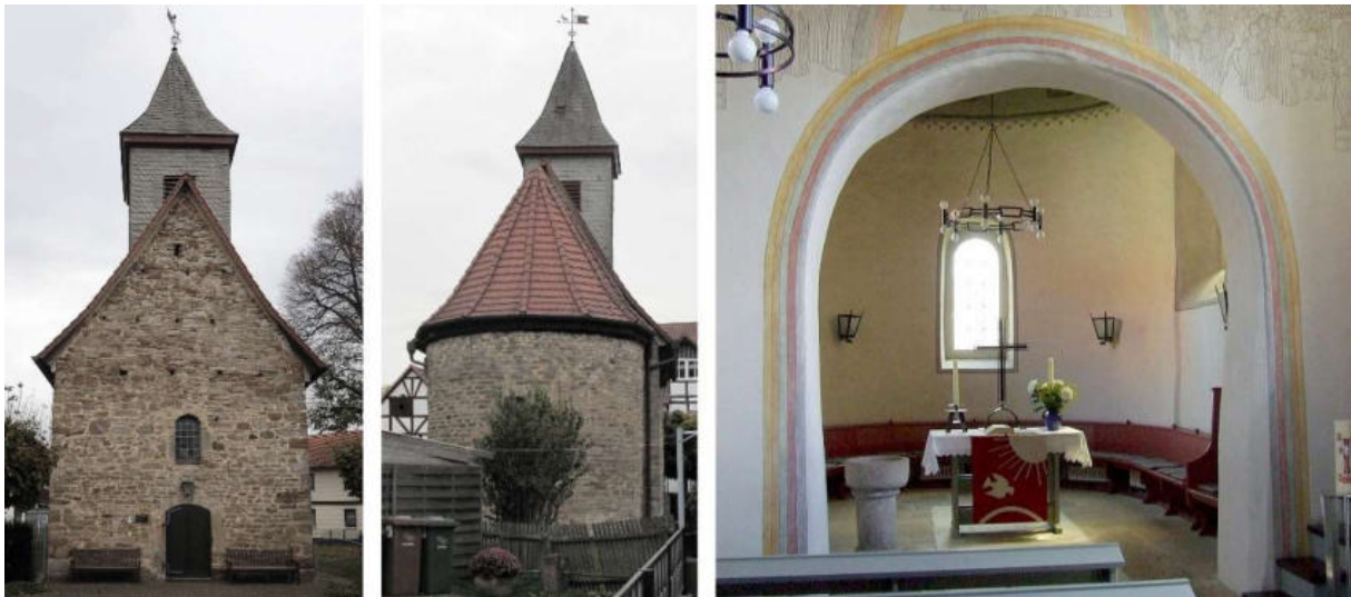
Abb. 100: Kirche in Holzhausen – West- und Ost-Ansicht, Blick in den Chor [4]
