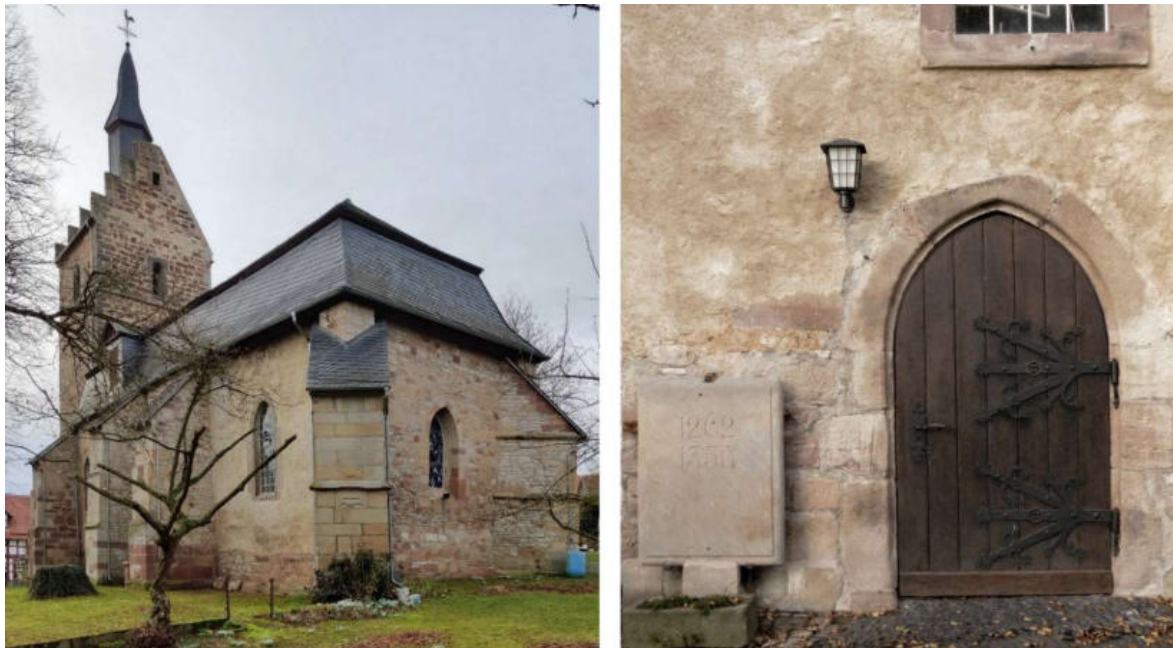
Abb. 104: Kirche in Niederelsungen – Südost-Ansicht, Süd-Portal (von links)
