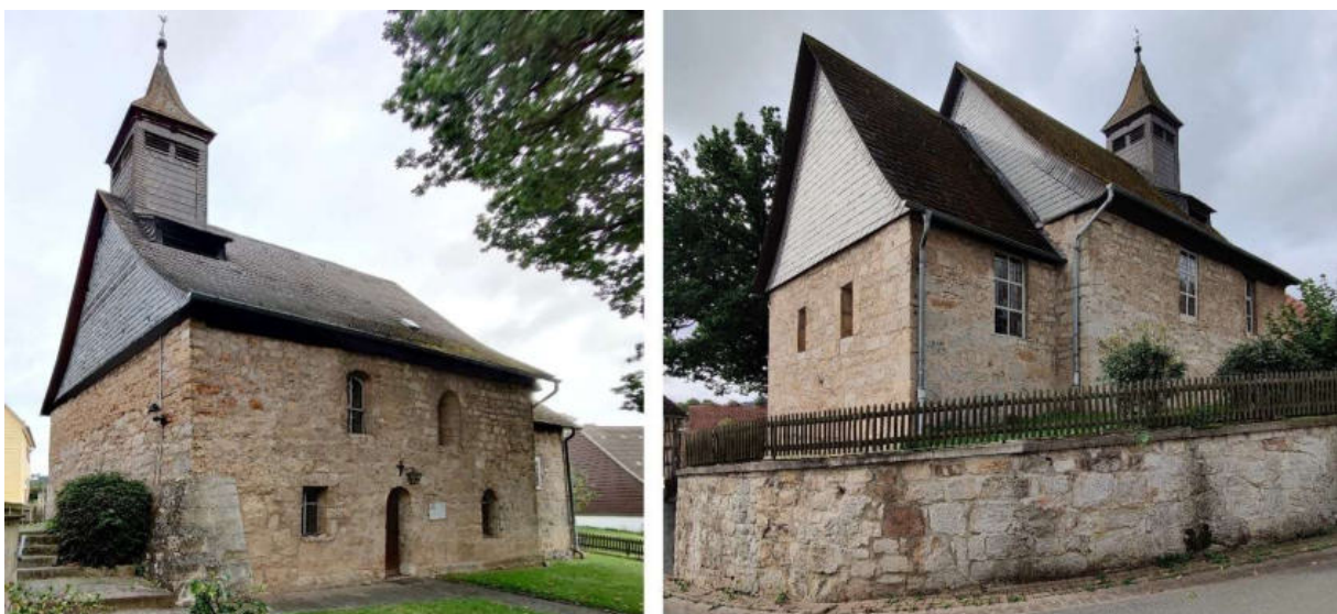
Abb. 93: Kirche in Lelbach – Südwest-Ansicht, Nordost-Ansicht (von links)
