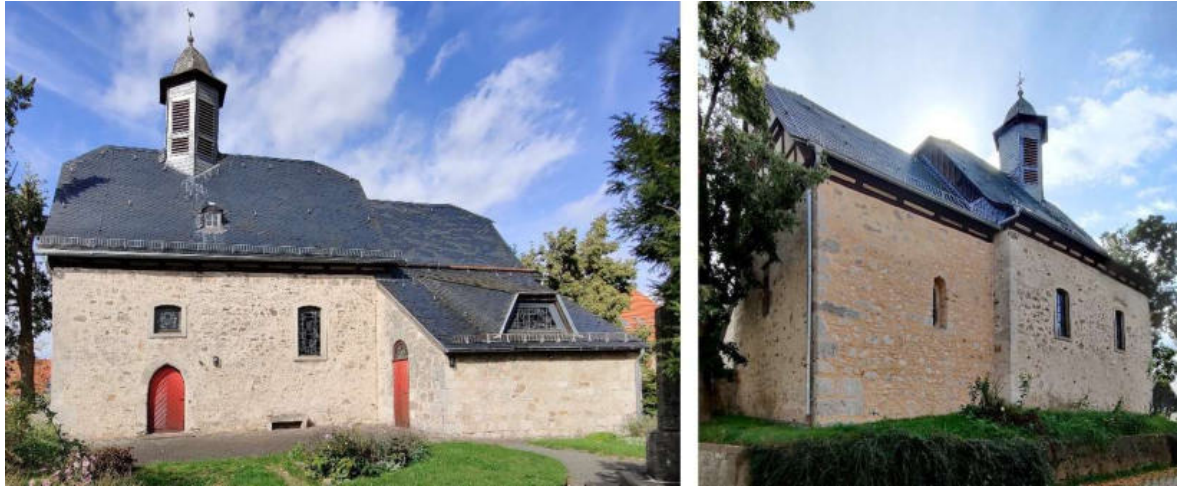
Abb. 97: Kirche in Marienhagen – Süd-Ansicht, Nord-Ansicht (von links)
