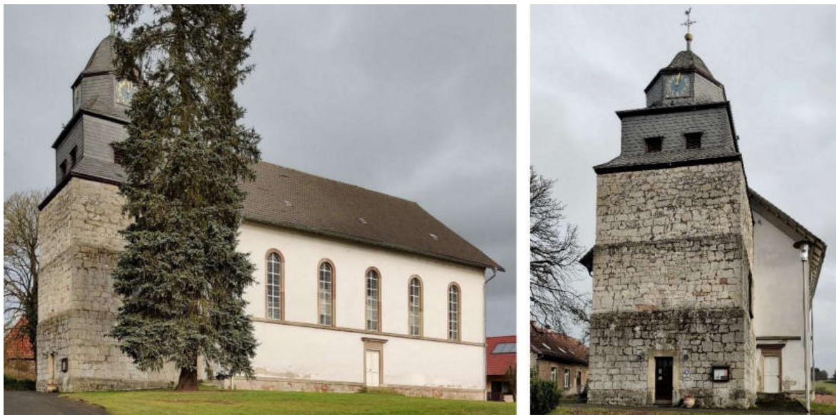
Abb. 109: Kirche in Vöhl – Südwest- und Westansicht (von links)
