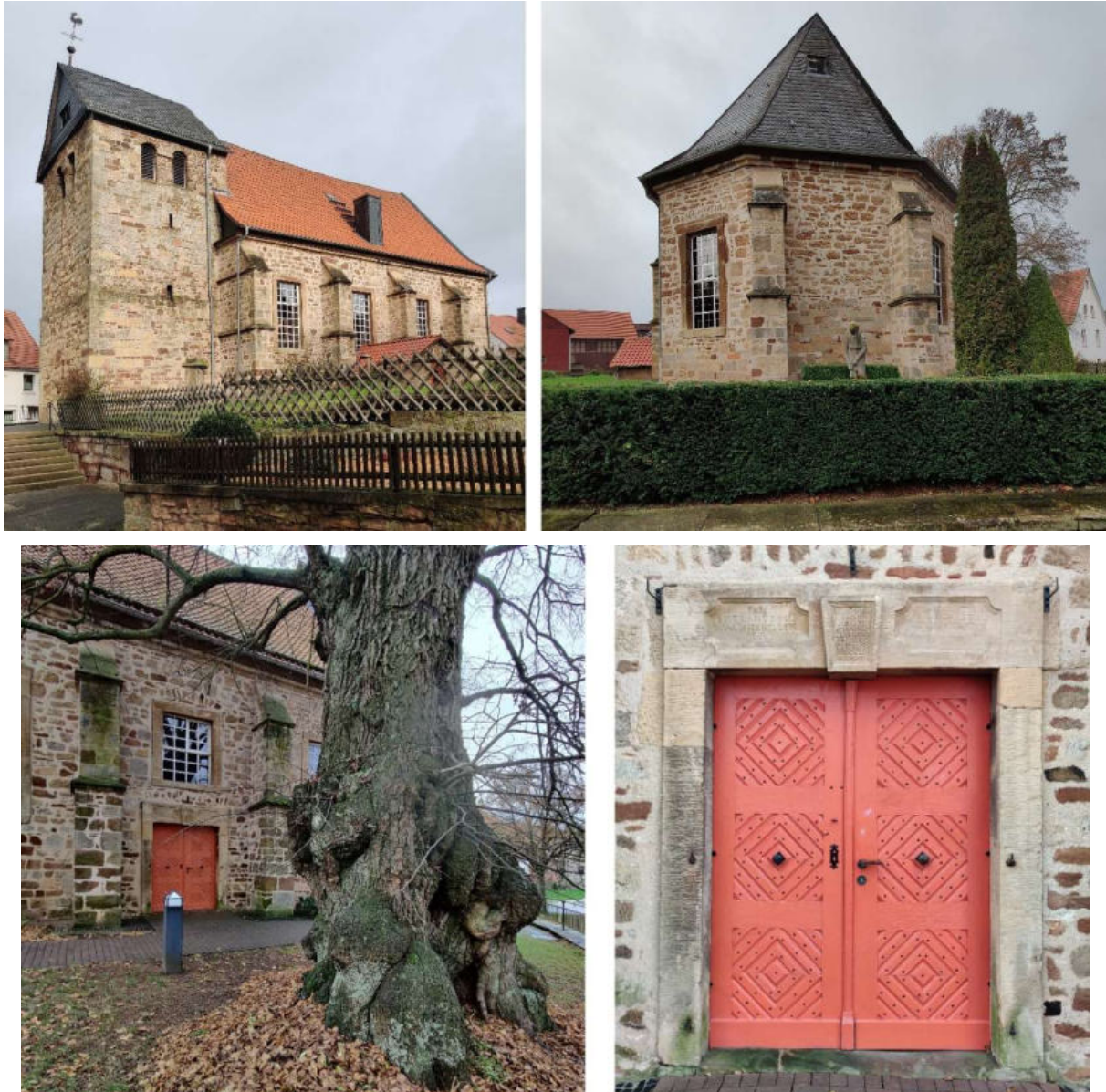
Abb. 133: Kirche in Meininghausen – oben: Südwest-Ansicht, West-Ansicht unten: Nord-Ansicht, Nord-Portal (jeweils von links)
