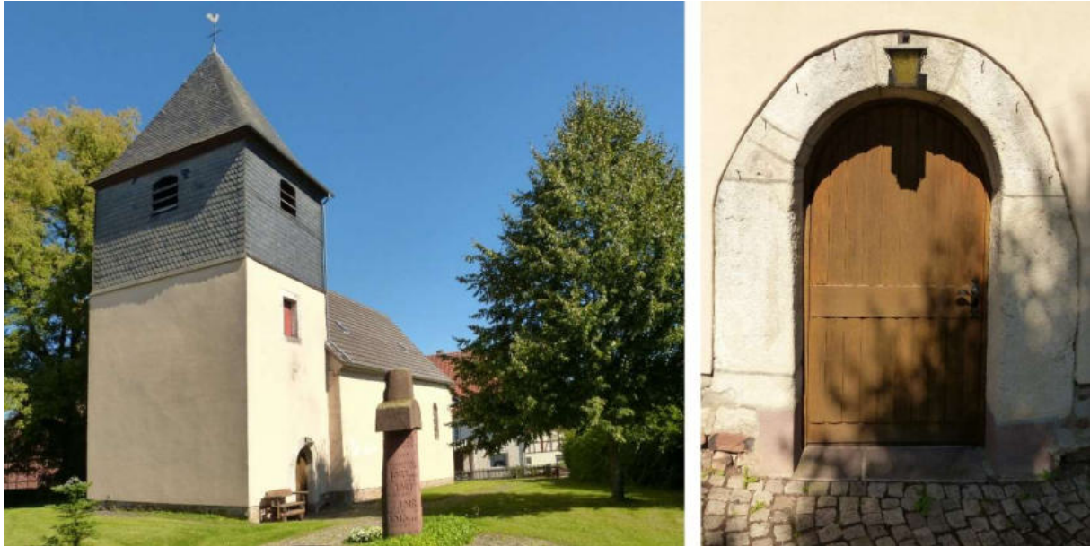
Abb. 126: Kirche in Massenhausen – Südwest-Ansicht, Süd-Portal (von links)
