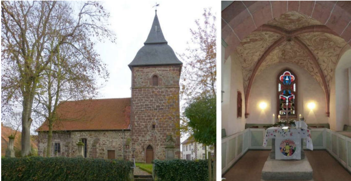
Abb. 112: Kirche in Ehringen – Nord-Ansicht, Blick in den Chor [4]
