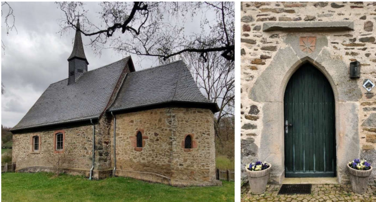
Abb. 88: Kirche in Frebershausen – Südost-Ansicht, Nord-Portal
