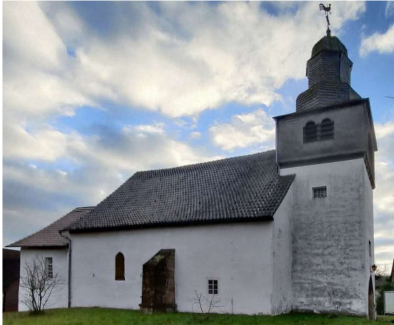
Abb. 77: Kirche in Helmighausen – Nord-Ansicht
