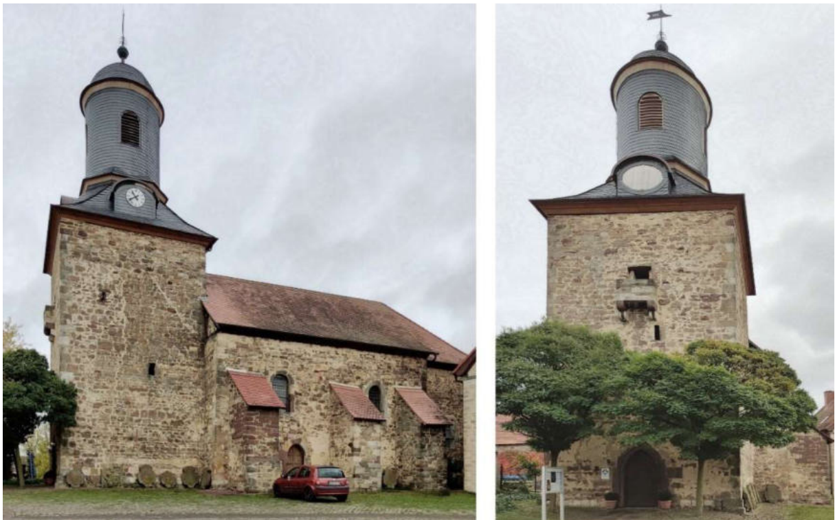
Abb. 52: Kirche in Burguffeln – Süd- und West-Ansicht (von links)
