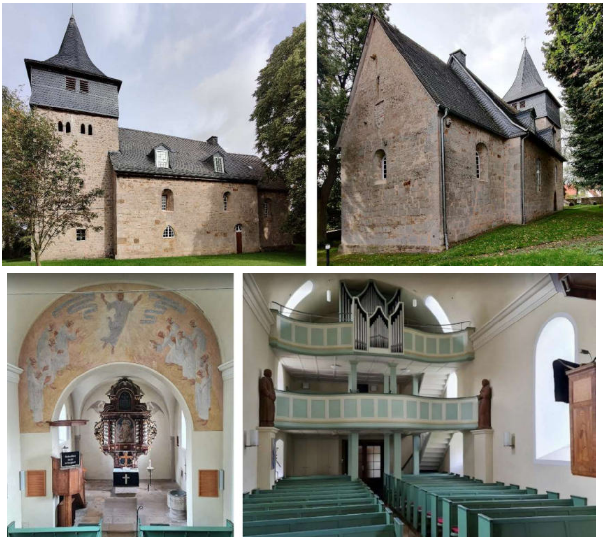
Abb. 60: Kirche in Nieder-Ense – Süd- und Nordost-Ansicht (von links) unten: Innenansichten
