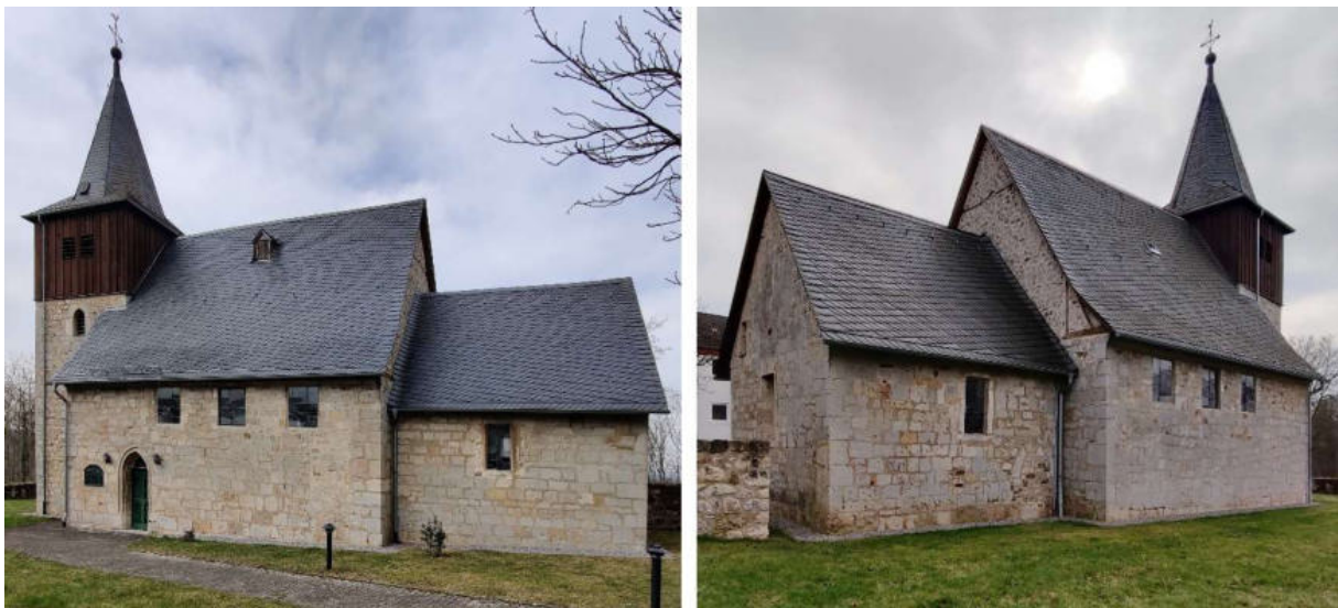
Abb. 68: Kirche in Obernburg – Süd- und Nordwest-Ansicht (von links)
