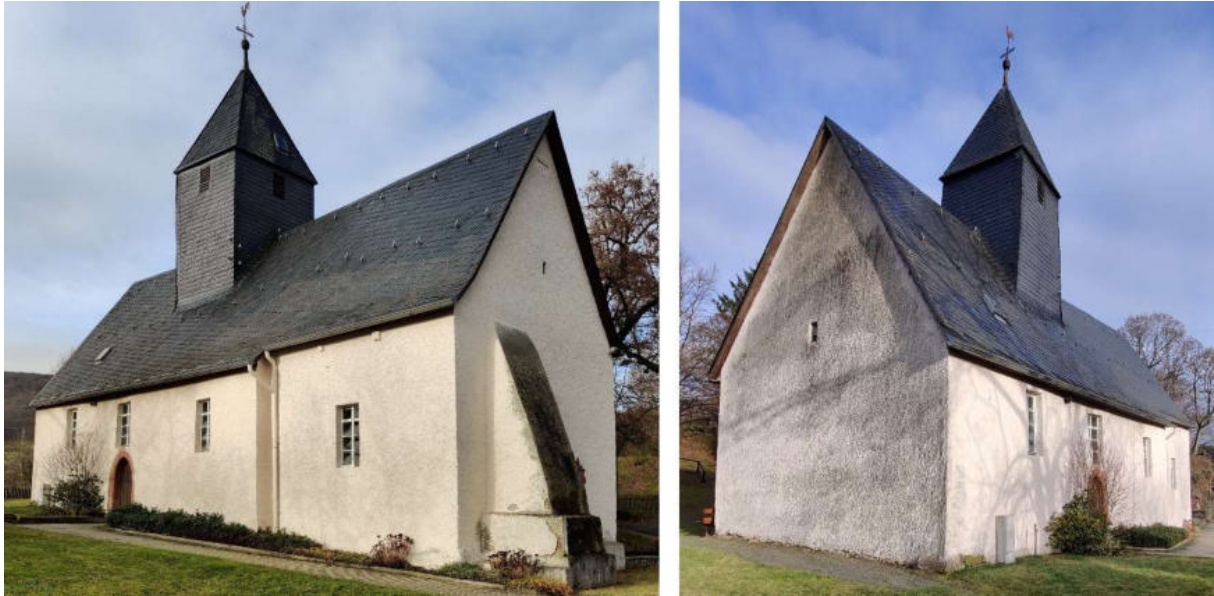
Abb. 87: Kirche in Gellershausen – Süd- und Südwest-Ansicht
