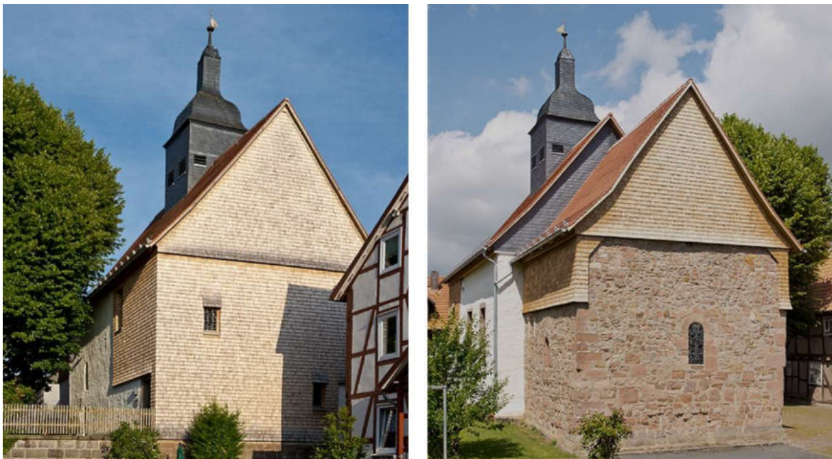
Abb. 78: Kirche in Mandern – Ansichten von Nordwest und Südwest
