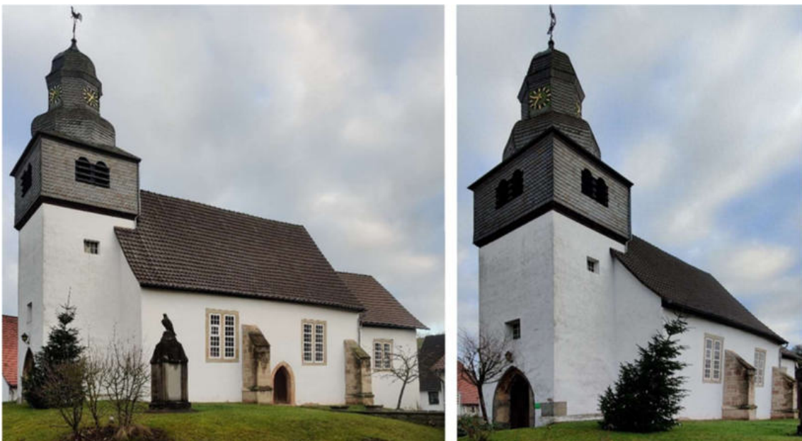
Abb. 76: Kirche in Helmighausen – Ansicht von Nord- und Südost (von links)
