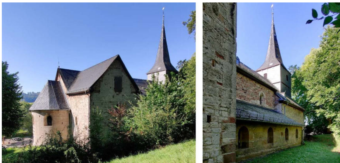
Abb. 18: Kirche in Twiste – oben: Südost-Ansicht, Süd-Portal (von links) unten: Nordost-Ansichten
