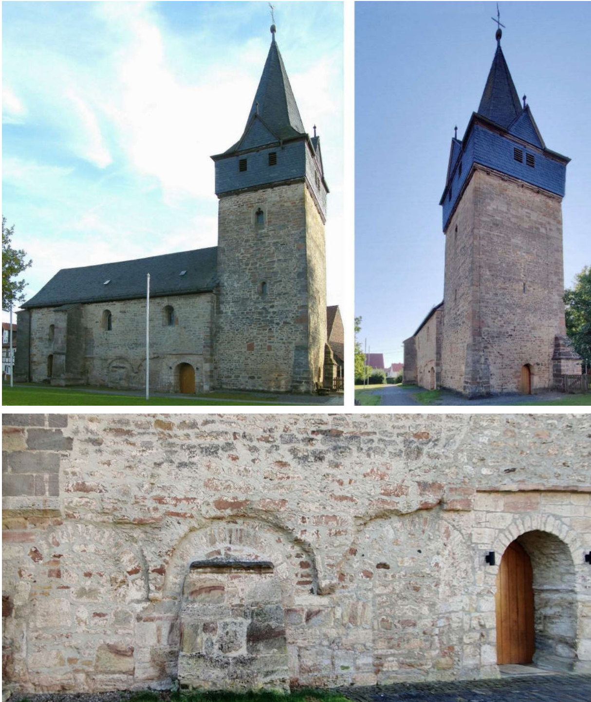
Abb. 39: Kirche in Mühlhausen – oben: Nord- und West-Ansicht (von links) unten: Vermauerte Arkaden mit Nordportal
