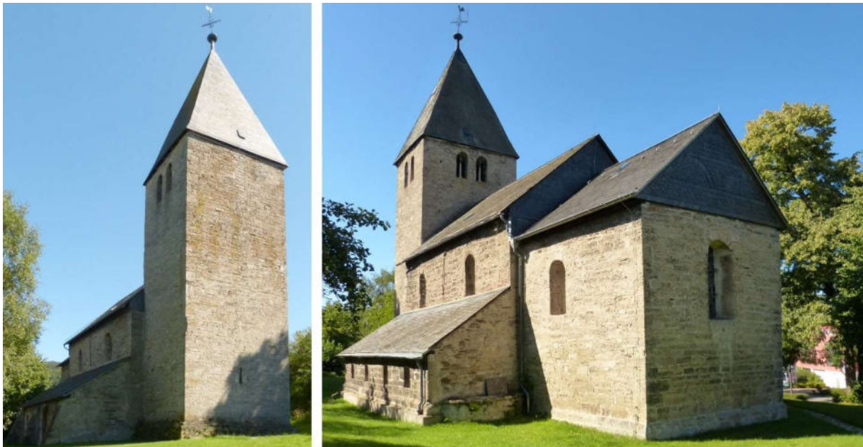
Abb. 26: Kirche in Heringhausen – Außenansichten von Nordwest und Südost (rechts)
