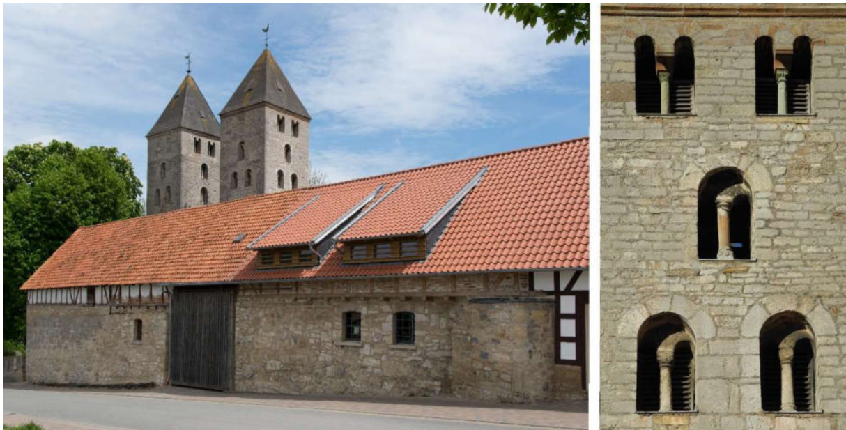
Abb. 33: Kirche in Flechtingen – Klostergebäude von Südwest, Schallarkaden am Nordturm
